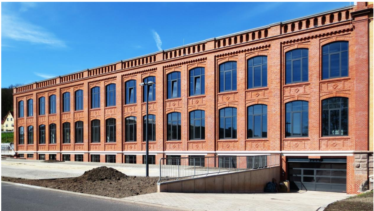
Ansicht Osten mit Zufahrt und Sektionaltor zum Untergeschoss
