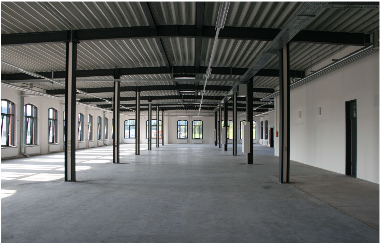
Flächen im Obergeschoss – nach Sanierung
