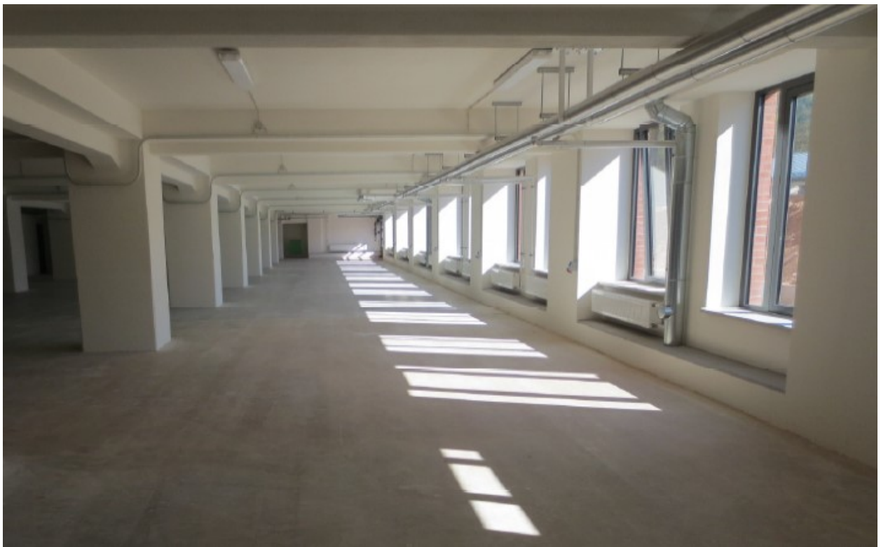
Flächen im Untergeschoss – nach Sanierung
