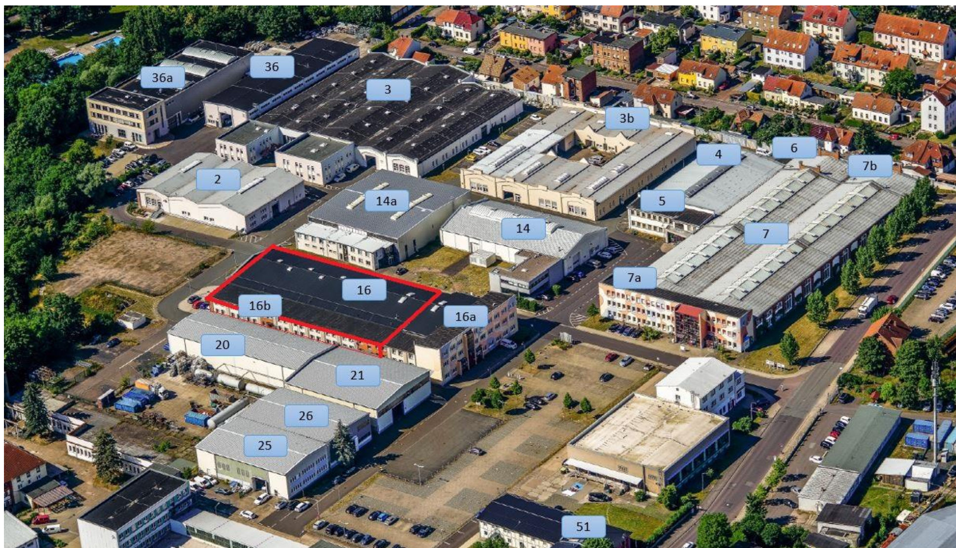
Luftbild Liegenschaft Südstraße 15
